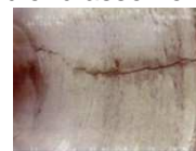
Fissure longitudinale ouverte:
